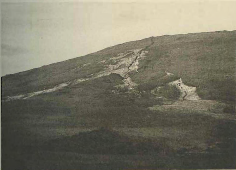
2. Les 2 fissures (3 et 4).
